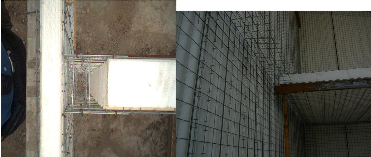
La fotografía muestra el espacio libre para rellenar de hormigón en la unión entre el panel vertical y el losa. Sólo falta colocar la armadura pasante de 1  $\Phi$  6 separados según cálculo del cortante en la unión.
