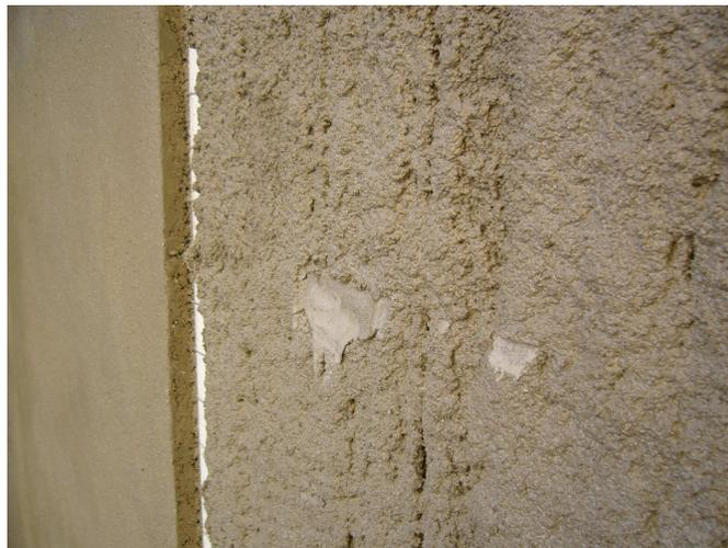
En la fotografía se aprecia la huella dejada por la maestra y los espesores de primera capa a la derecha y de segunda capa terminada por la izquierda.
